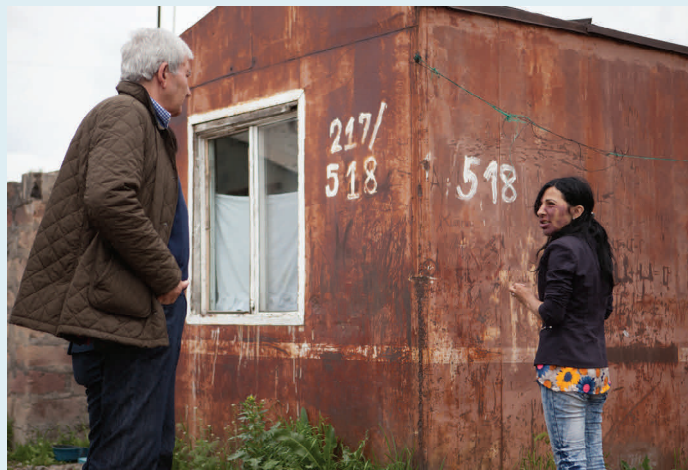
Abb. 2: Hr. Moumdjian wirft hier einen Blick auf den Zustand der Blechhütten. Dort wohnte Ruzanna Yeghoyans Familie
